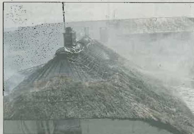
Tout le chaume restant devait être ôté hier soir, pour éviter les reprises de feu.
